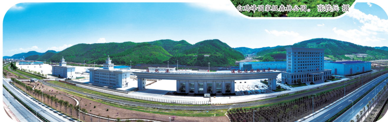
吉林通化国际内陆港务区辖区通化港、保税物流中心(B型)、公路集装箱中心站、陆港大道项目。王斌鹏 摄
