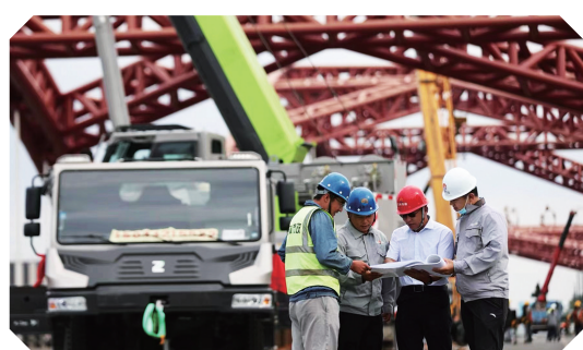
吉林市政建设集团桥梁公司施工人员在江湾大桥改造中研究施工图纸。
