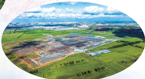
建设中的奥迪一汽新能源汽车项目。
