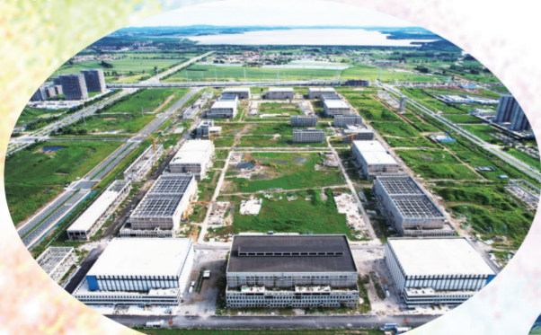
长春国际影都影视拍摄基地一期20个摄影棚建设主体工程基本完工。
