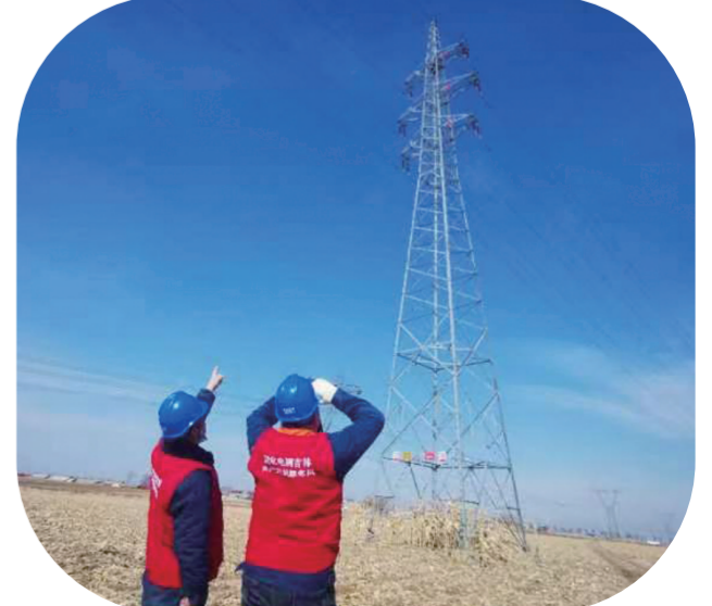
日前，国网永吉供电公司重要输电线路和重要变电站进行特殊巡视，有效保障老百姓安心用电可靠用电。
