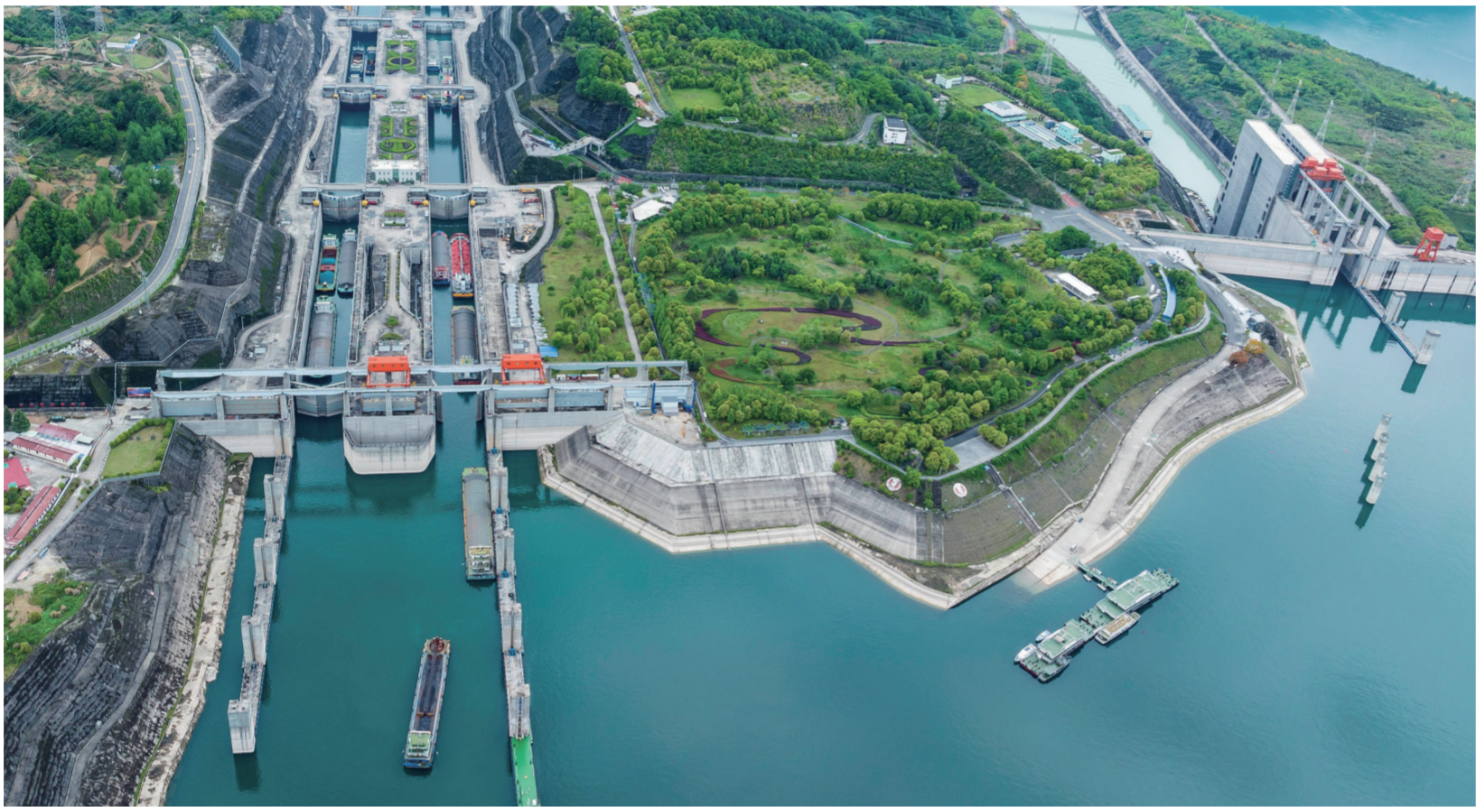
4月24日，船舶有序通过三峡双线五级船闸(无人机照片)。据三峡集团消息，过去五年，三峡船闸航运效益节节攀升，年货运量连续五年突破1亿吨，累计过闸货运量超7.3亿吨，成为长江经济带高质量发展重要物流通道。新华社发(郑家禧 摄)
