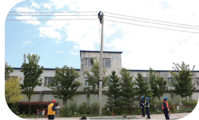
日前，国网吉林供电公司开展“旗帜领航·建功新时代”职工技能竞赛，激励职工学技术、练技能、当能手、做贡献。图为参赛选手正在进行杆上作业竞赛。 刘宇航 摄
