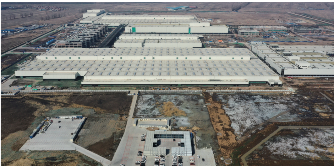
位于长春的奥迪一汽新能源项目施工现场（2023年3月9日摄，无人机照片）。新华社发（王勤 摄）
